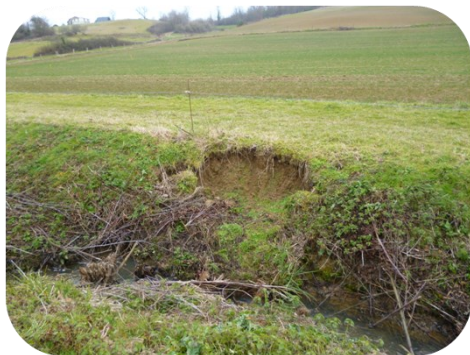
Pose d'une clôture démontable pour protéger la zone d'érosion
