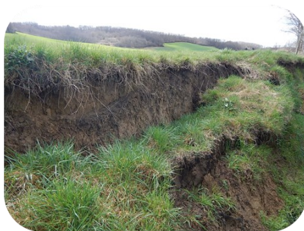
Erosion d'une berge
