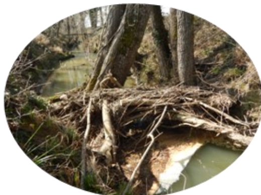
Embâcle peu problématique en aval de la prise d'eau du Thérondel
